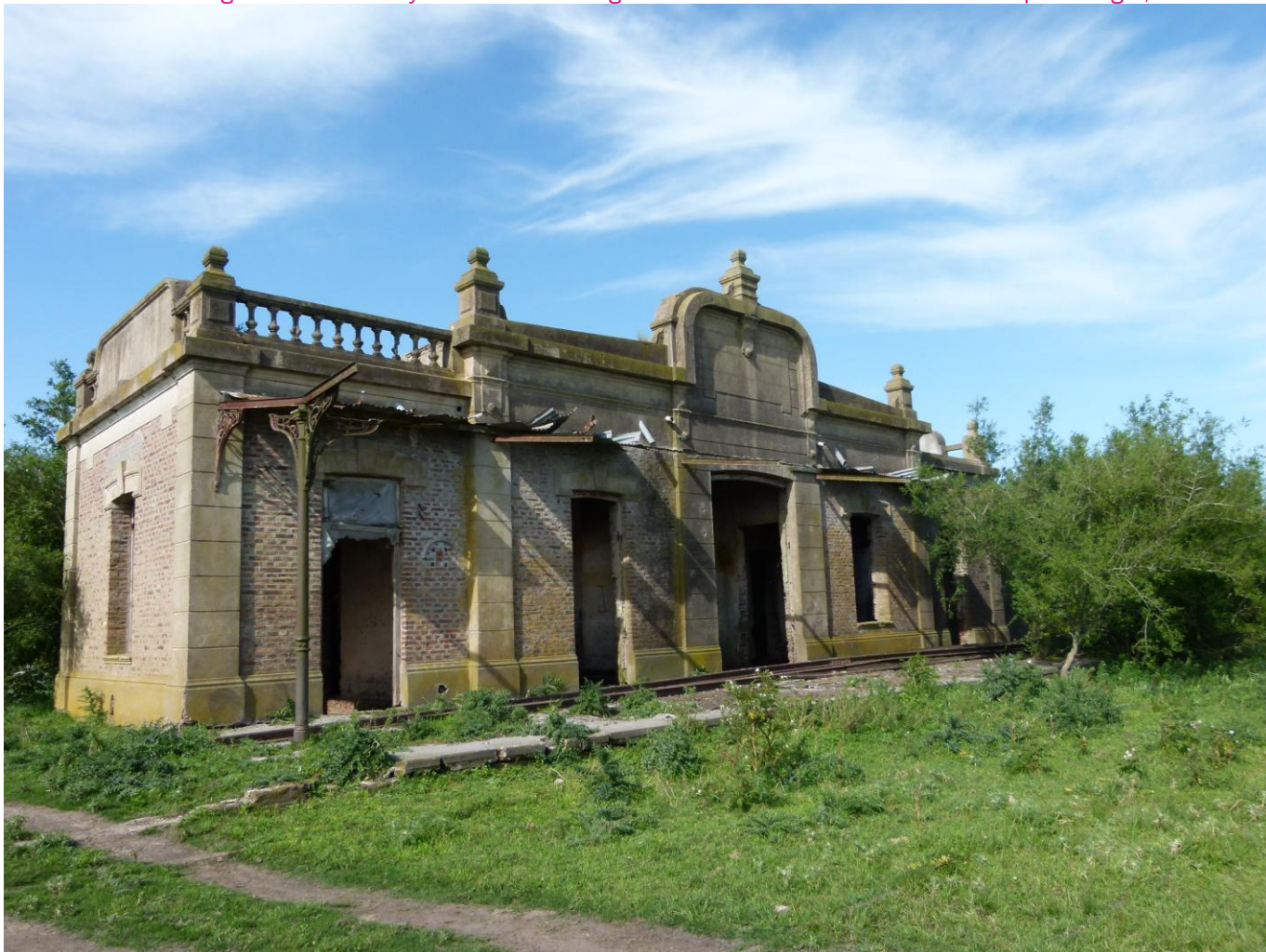
Fig. 2. El abandono y el vandalismo luego del cierre del ferrocarril. Estación Esquina Negra, La Plata.
