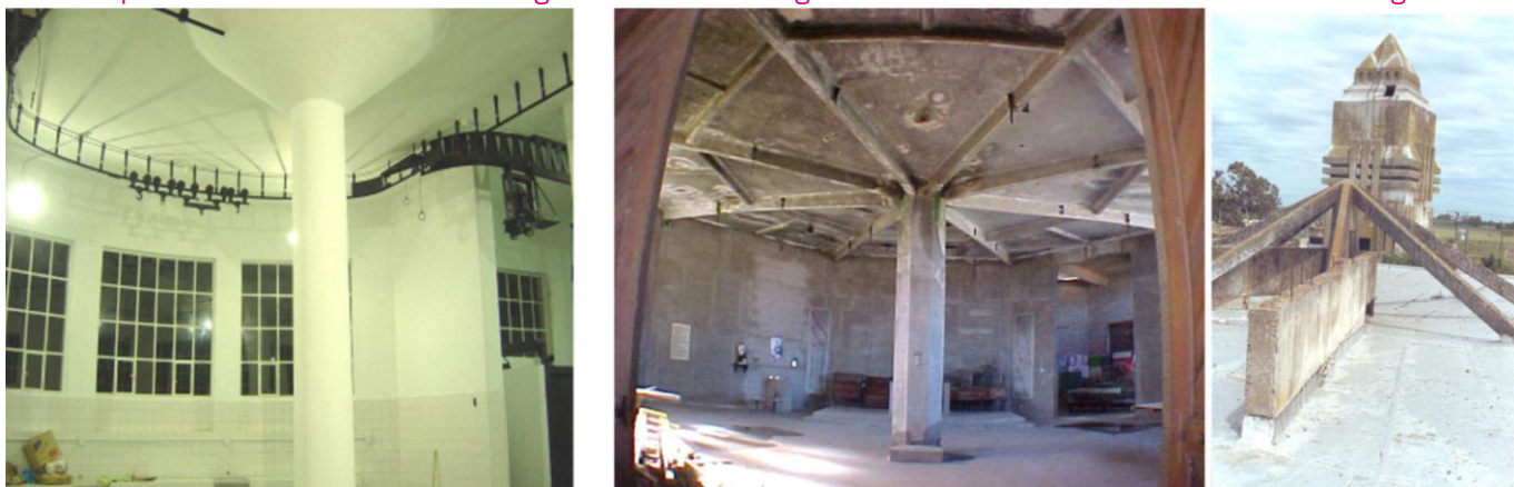
Fig. 4. Derecha: Estructura con Vigas acarteladas y columna central. Matadero de balcarce. Tensores tipo paraguas. Izquierda: Estructura de losas sin vigas con columna fungiforme. Matadero de Tres Lomas. Columna fungiforme.
