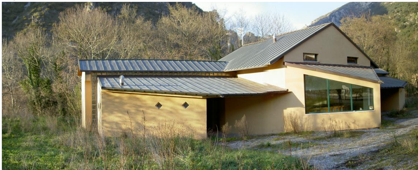
Fig. 3. Centro de Interpretación de Tuñón, en estado de semiabandono, antes de su concesión a una empresa de turismo activo.
