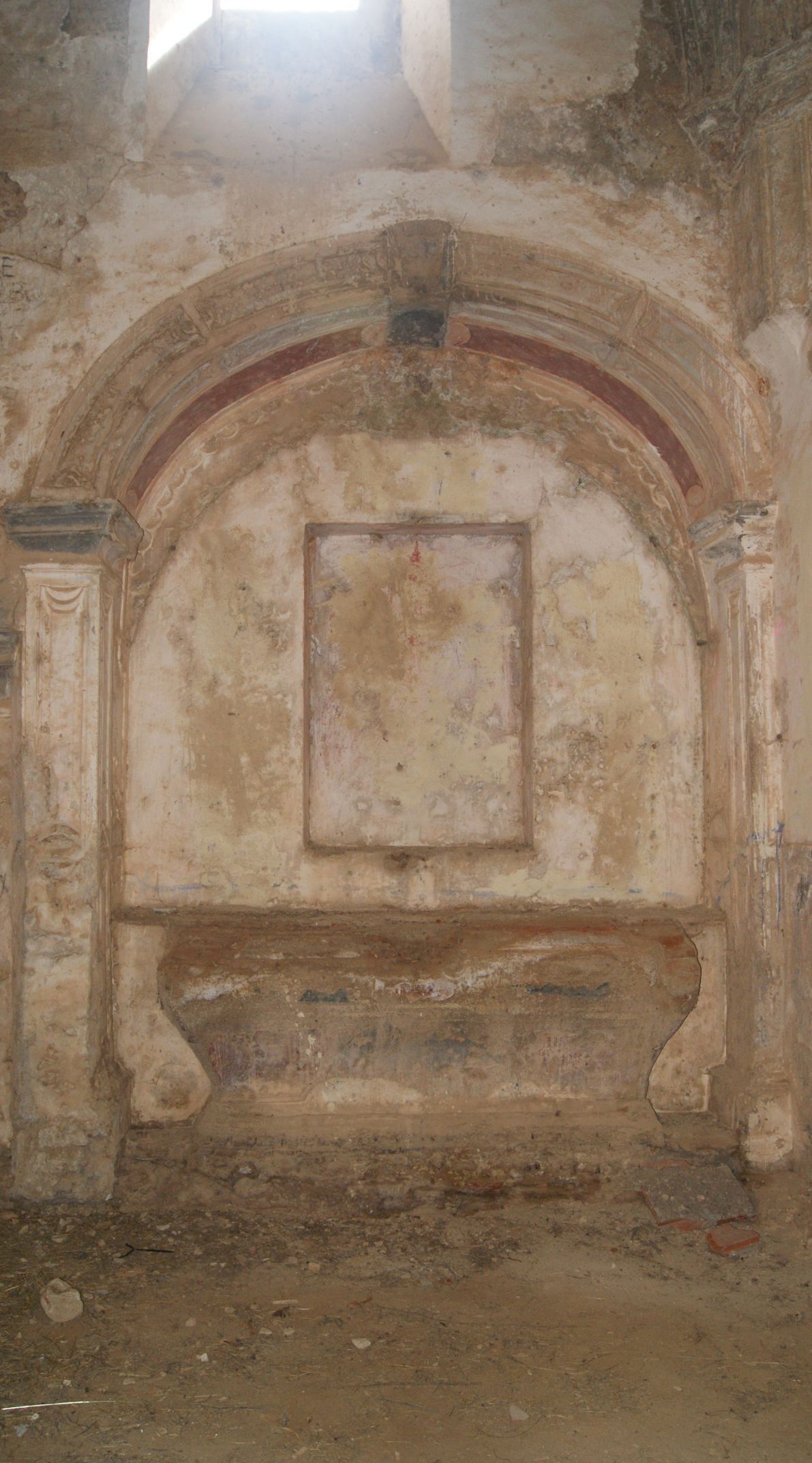
Detalle de la capilla lateral derecha.
