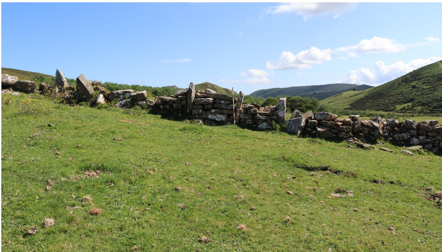
Cierre en los Caniel.los. En las trazas murarias se aprecia los diferentes “pasos” que deberían se abiertos o cerrados (con piedra en seco) según se encuentre acotada o en derrota la vega.
