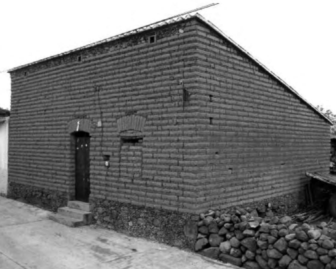
Figura 2. Vivienda tradicional de los altos de Morelos, construcción ubicada al frente del solar, rodapié de piedra de toba volcánica, muros de adobe, dinteles de adobe en vanos de puertas y ventanas, cubierta inclinada al interior del terreno. Imagen “La casa tradicional de adobe en Yecapixtla, Morelos: un análisis tipológico, Meraz. (GUERRERO y SORIA, 2010:160).
